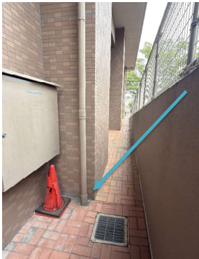
③2本目の柱の縦樋足元にキーボックスあり
